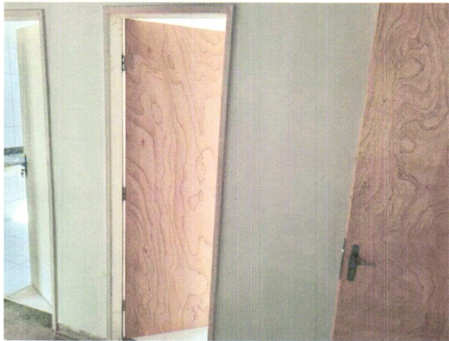
FOTO 02 – INSTALAÇÃO DE PORTAS DE MADEIRA INCLUSIVE ALIZAR
