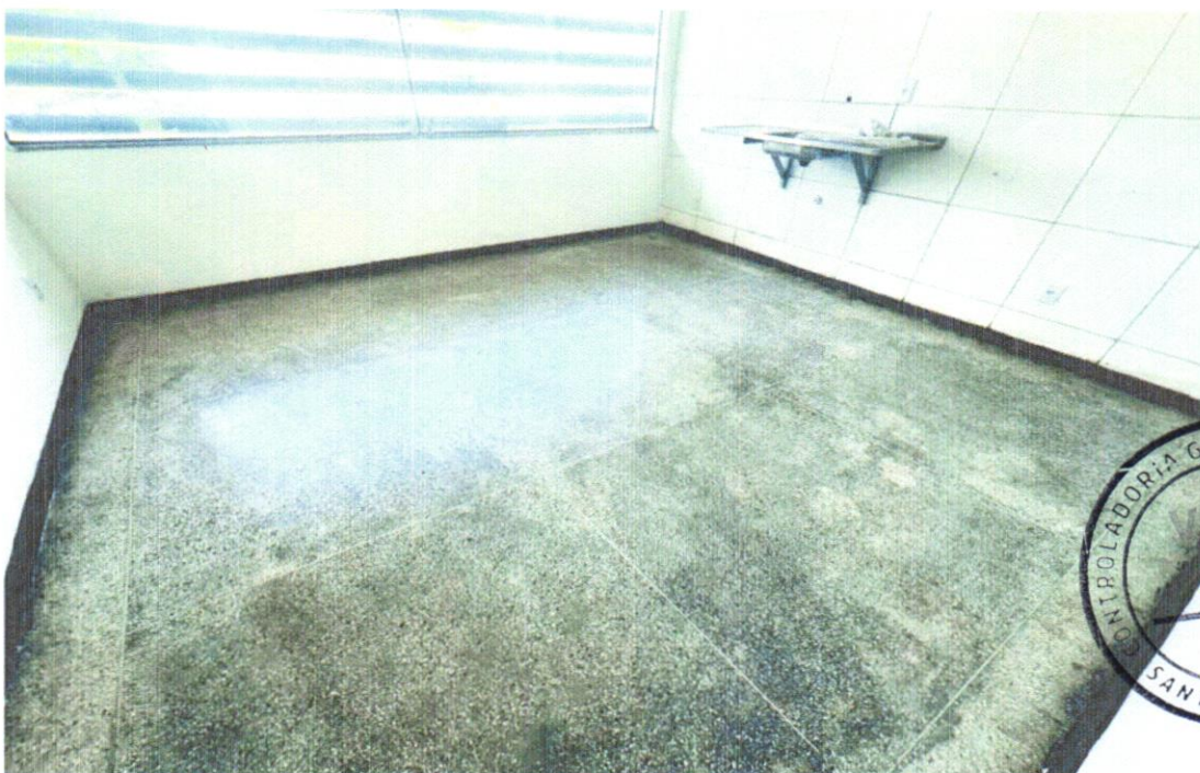
FOTO 18 – POLIMENTO DO PISO DE ALTA RESISTÊNCIA
