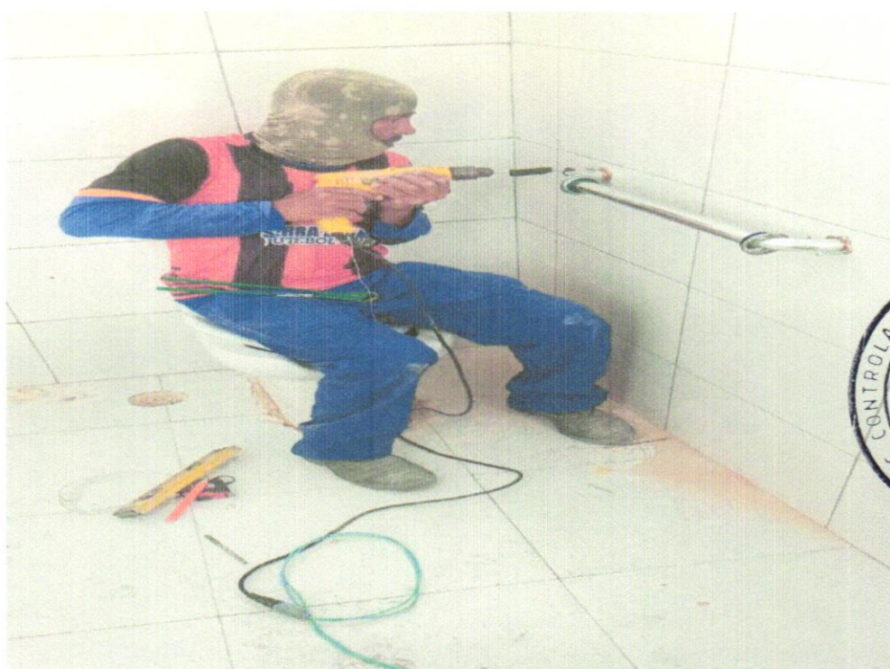
FOTO 12 – INSTALAÇÃO DA BARRA DE APOIO SANITÁRIO PCD
