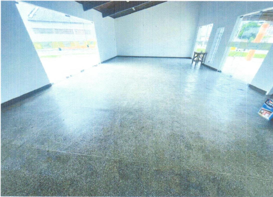
FOTO 18 – POLIMENTO DO PISO DE ALTA RESISTÊNCIA
