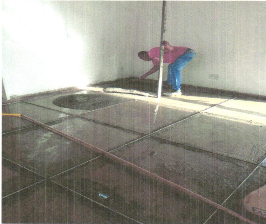
FOTO 16 – EXECUÇÃO DO PISO DE ALTA RESISTÊNCIA
