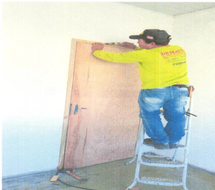
FOTO 02 – INSTALAÇÃO DE PORTAS DE MADEIRA INCLUSIVE ALIZAR
