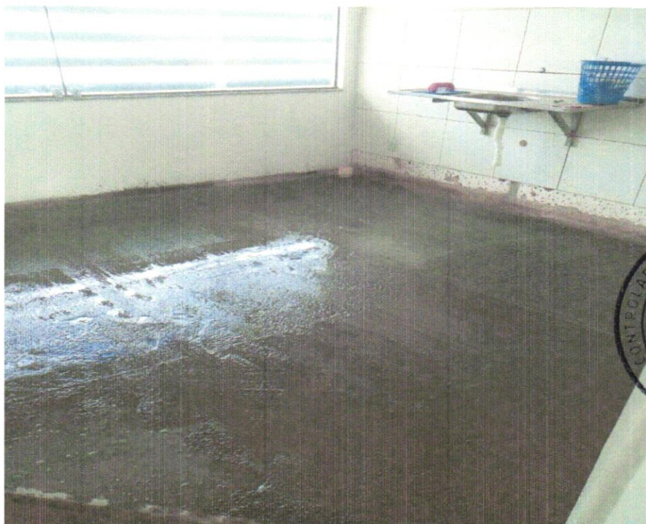
FOTO 16 – EXECUÇÃO DO PISO DE ALTA RESISTÊNCIA
